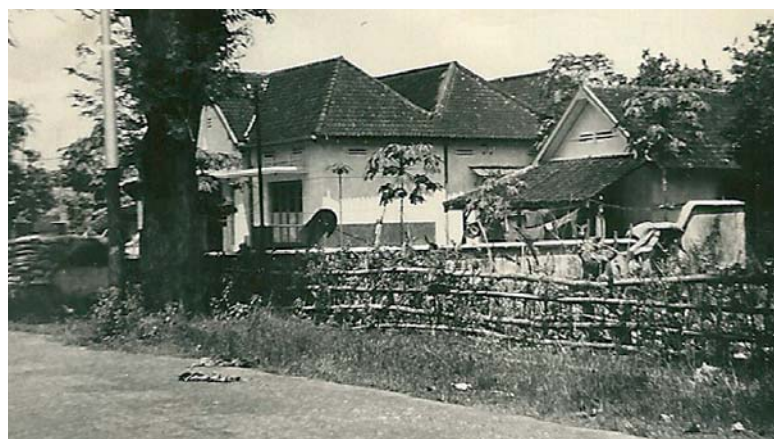
Detachementsgebouw in Kediri, foto beschikbaar gesteld door Charl Besançon.
