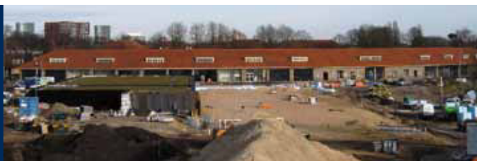
December 2013. De renovatie van gebouw 55 is een heel eind op weg. Op de voorgrond steekt de sportruimte deels boven de grond uit
