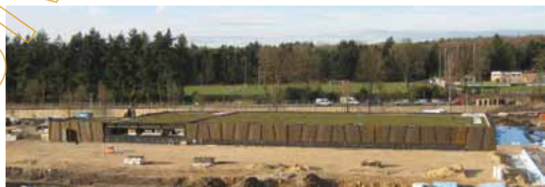
December 2013. De sporthal steekt 2.70 m boven het maaiveld uit. Deze is rondom voorzien van gevelementen van zogenaamd cortenstaal. Kenmerk hiervan is dat het na enige tijd gaat oxideren, zodat een roestkleurige gevel ontstaat. Op het dak is begroeiing van sedum (vetplanten) aangebracht
