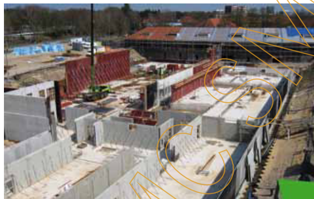
Voorjaar 2013. Op de achtergrond gebouw 55 letterlijk in de renovatiesteigers. Op de voorgrond de ondergrondse sport- en schietfaciliteiten in aanbouw
