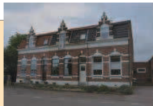
Voormalige marechaussee-kazerne Ossendrecht
