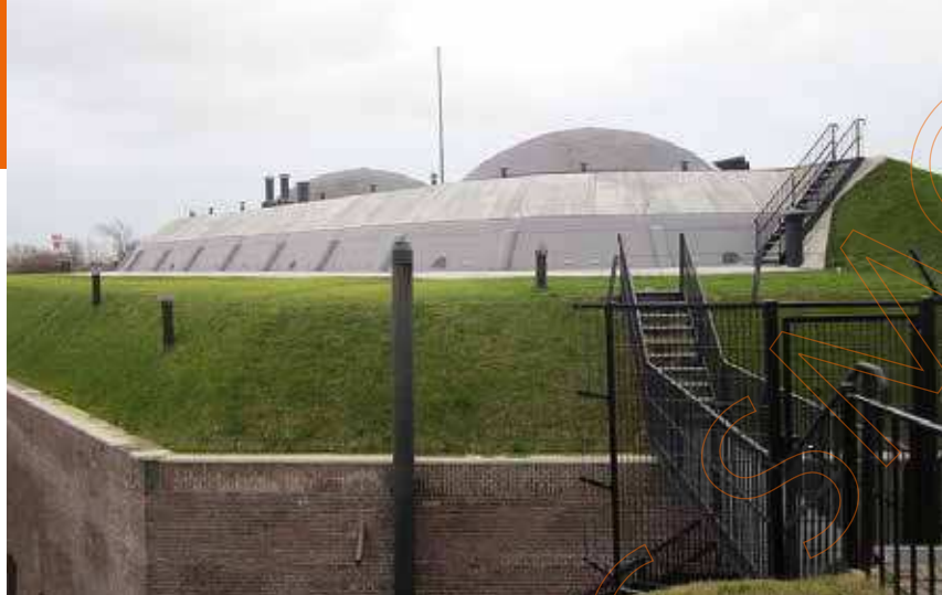
De geweergalerij (buitenzijde) van Fort aan den Hoek van Holland
