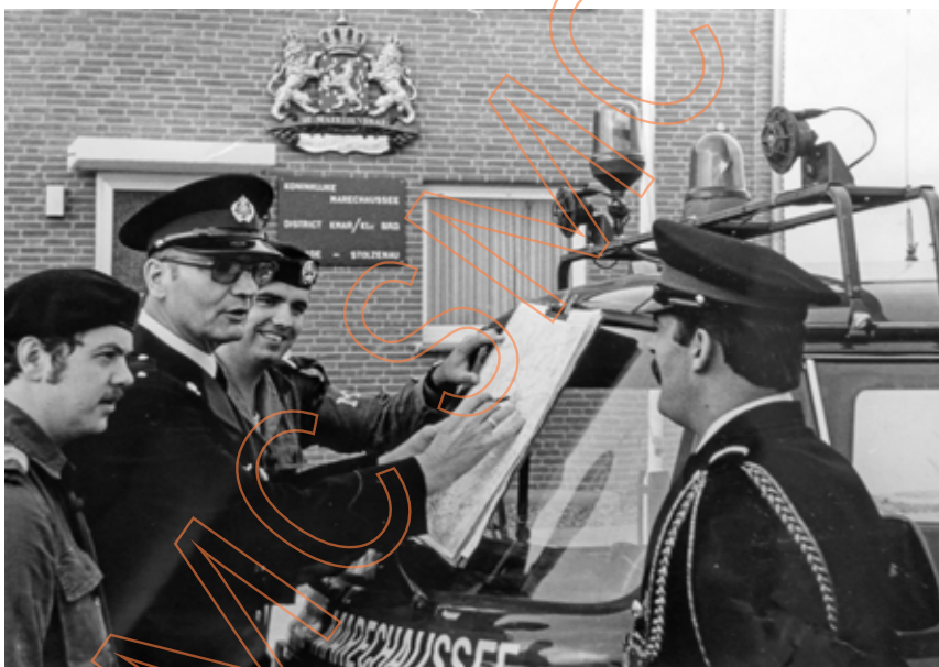
1977, foto ter gelegenheid van de ingebruikname van het nieuwe brigadegebouw met als bijschrift in een krantenartikel: "Einsatzbesprechung vor der neuen Dienststelle in der Stolzenauer Wilhelm-Busch-Straße zwischen Adjutant Simon Pieter Niehof (Zweiter von links), dessen Stellvertreter Wachtmeister 1. Klasse Eelco Bouwman (rechts) sowie Wachtmeister Joost Molenkamp (Dritter von links) und Marechaussee Piet Wijkhuijs (links)"
